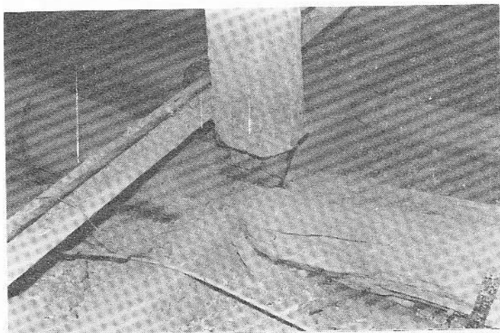
Poinçon du tourniquet, il s'est affaissé de 40 cm, l'ensemble est changé en totalité.
