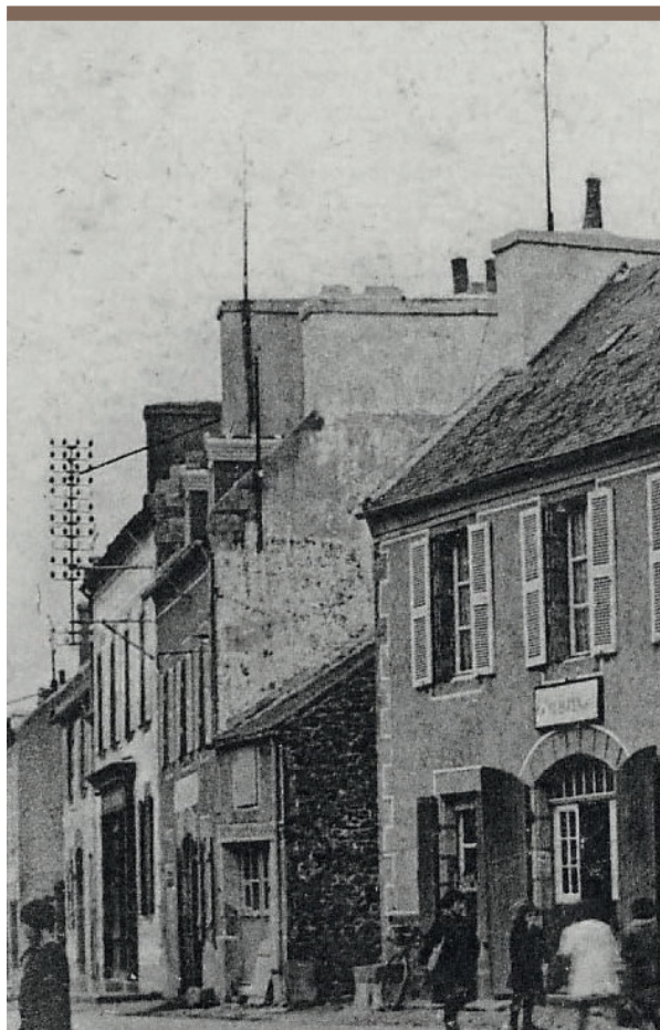
Vers 1930 - Mâts sur les cheminées pour l'électricité
